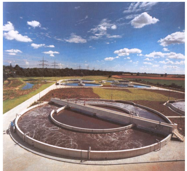
Belüfterbecken der Kläranlage Eschweiler.
